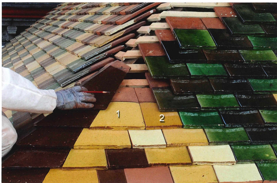
Chantier – Tournai : Cathédrale Notre-Dame – Chapelle Saint-Louis. La tuile 1 (commande spéciale) doit être deux fois plus large que la tuile de remplissage 2 permettant ainsi de façonner la contre-approche aux dimensions adéquates. G. Focant © SPW-AWaP
