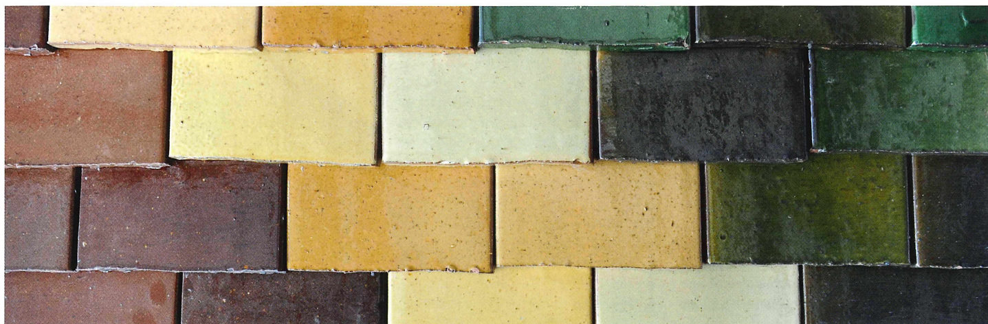
Découpe manuelle de la partie basse de la tuile offrant un alignement brouillé du pureau en phase avec l'esthétique des techniques anciennes. G. Focant © SPW-AWA/P
